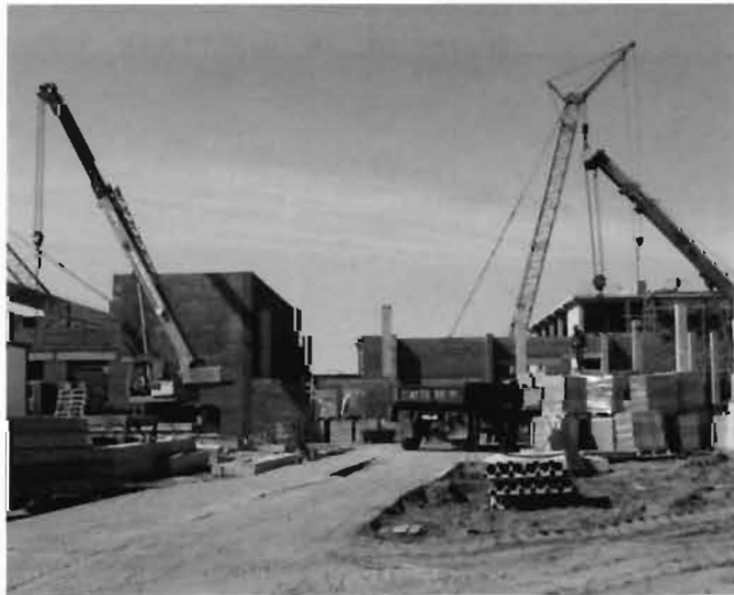
Строительство завода идет полным ходом
